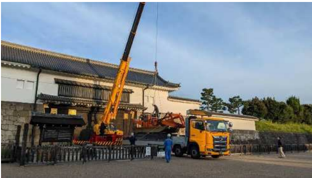
①藻上げ船着水作業（東大手門前）
