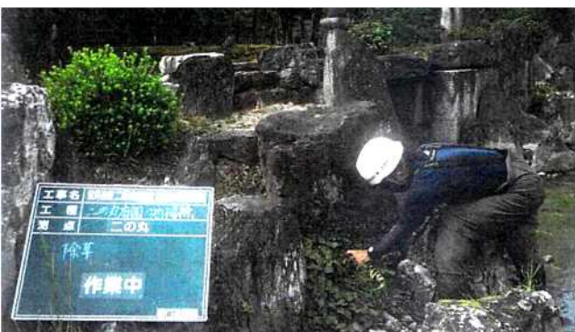
⑦ 護岸の雑草を除去
