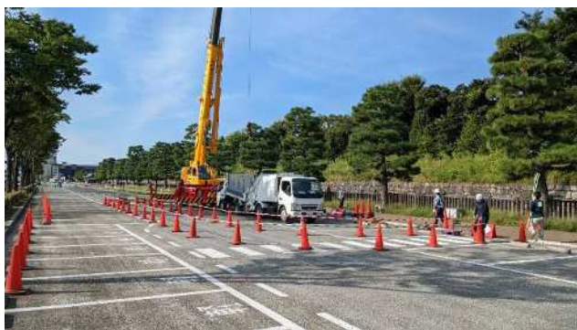
③駐車場内设営（歩行者迂回路設置）
