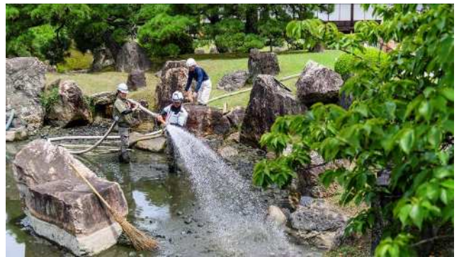
⑥ 消火栓の水で泥を洗い流しながら、泥を吸引 (④と⑥を繰り返す)
