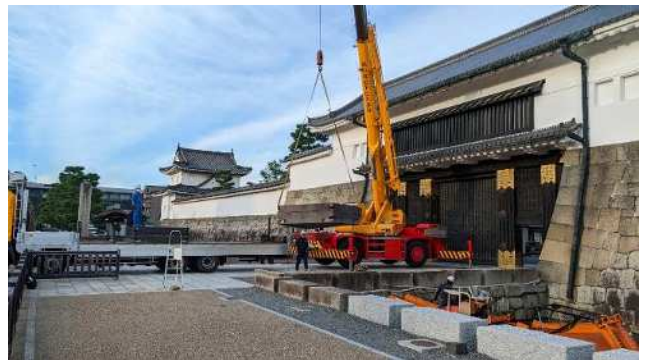
②台船着水作業
