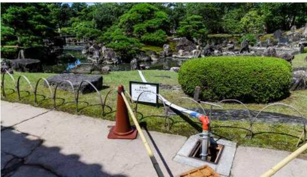
⑤ 消火栓にホースをセット
