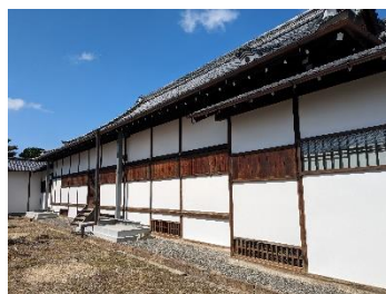
修理後（本丸御殿玄関） 耐震補強を施す
