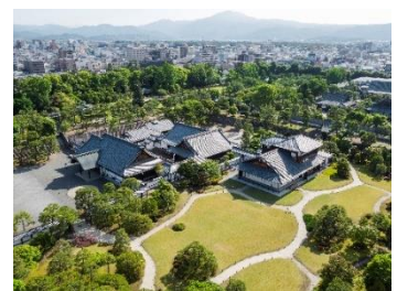
修理後（本丸御殿全景）
