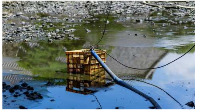
②水が抜き切らない場所は水中ポンプを使って水を排出
