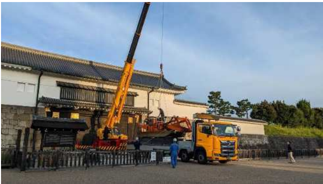
①藻上げ船着水作業（東大手門前）
