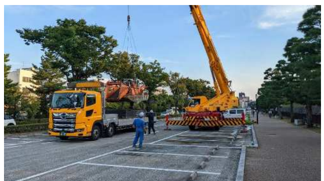
⑧台船、船を10t車に移動（移動後駐車場内清掃）
