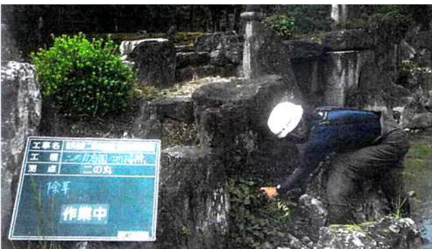
⑦護岸の雑草を除去
