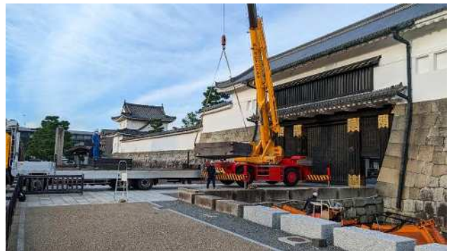
②台船着水作業
