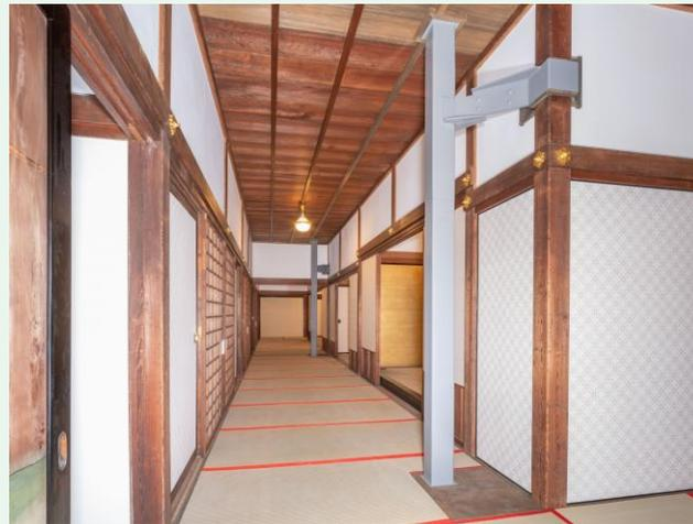
耐震補強の鉄骨柱（修理後）
