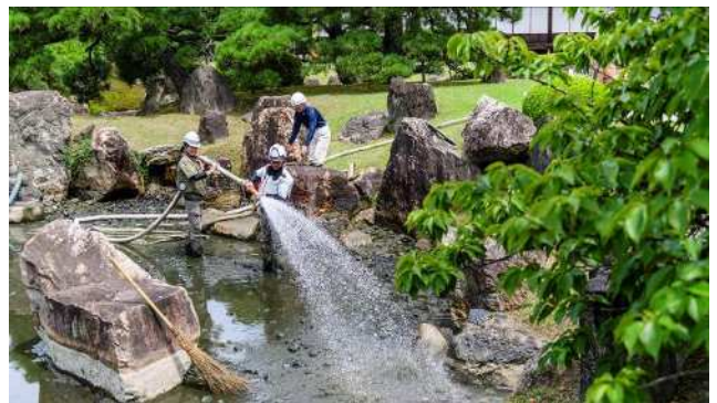
⑥ 消火栓の水で泥を洗い流しながら、泥を吸引 (④と⑥を繰り返す)
