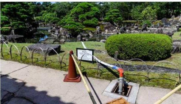
⑤ 消火栓にホースをセット
