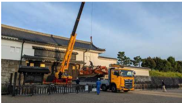
①藻上げ船着水作業（東大手門前）
