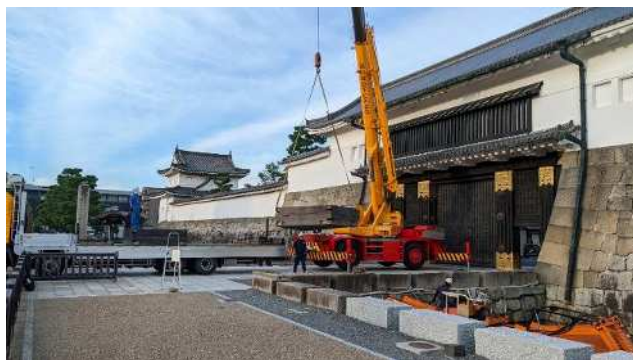
②台船着水作業
