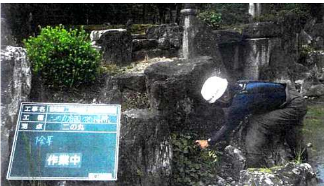
⑦ 護岸の雑草を除去
