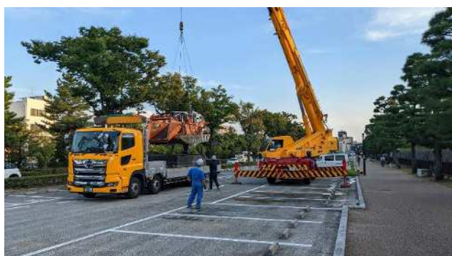
⑧台船、船を10t車に移動（移動後駐車場内清掃）
