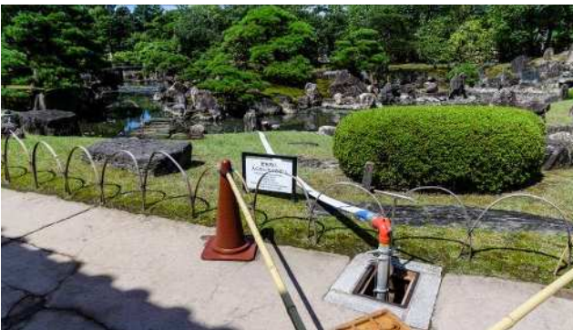
⑤消火栓にホースをセット
