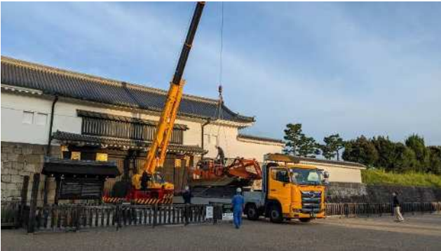
①藻上げ船着水作業（東大手門前）
