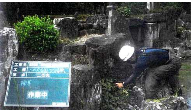
⑦護岸の雑草を除去
