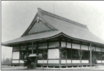
関西大学威徳館（大阪府吹田市）
